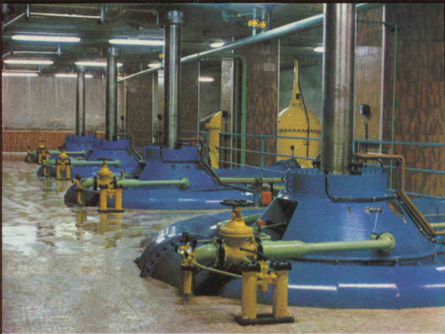
IMPULSIÓN DE OJÓS
