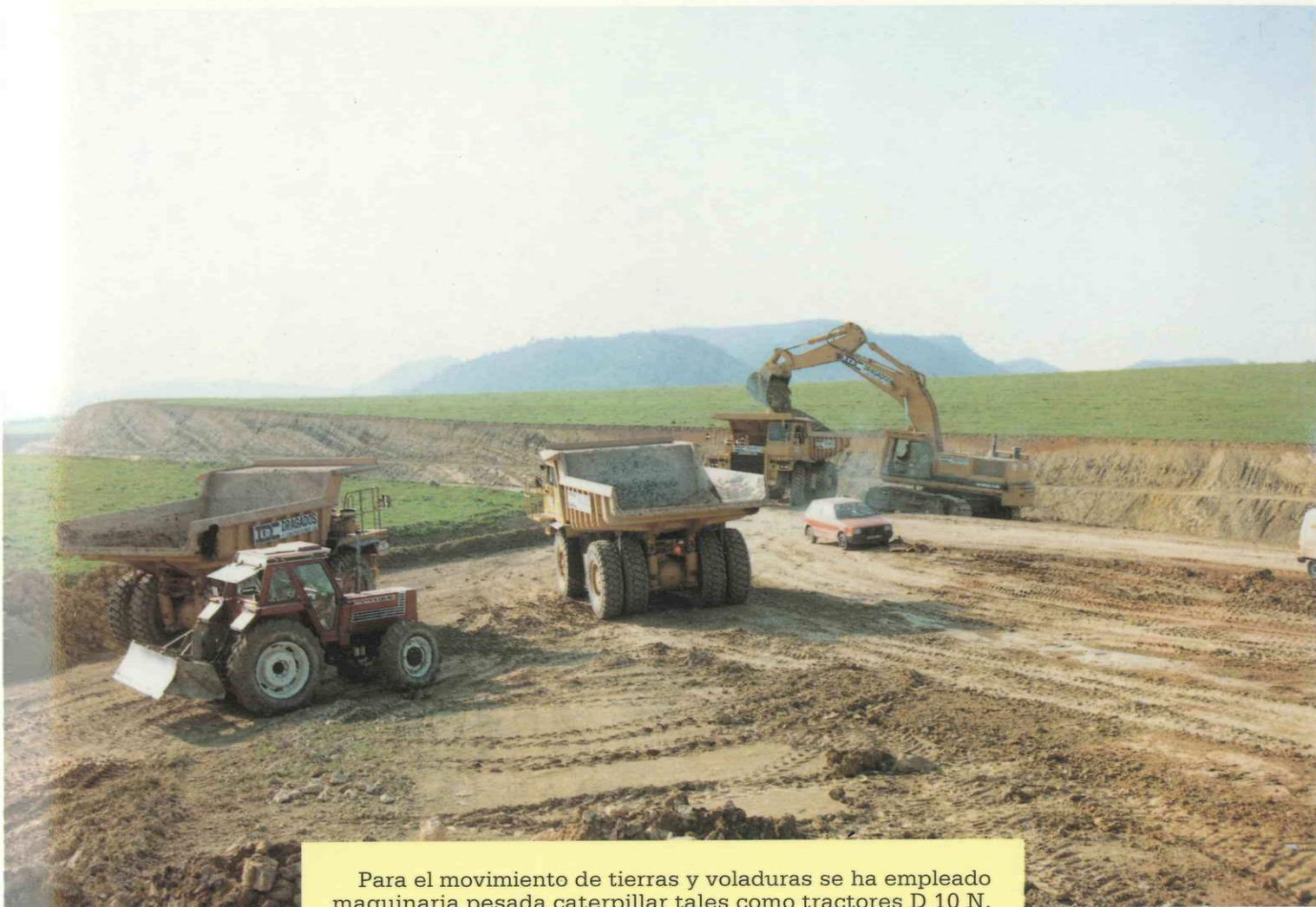
Para el movimiento de tierras y voladuras se ha empleado maquinaria pesada caterpillar tales como tractores D 10 N, palas 988 B, retroexcavadoras 245 B, motoniveladoras 14 G y 16 G.
