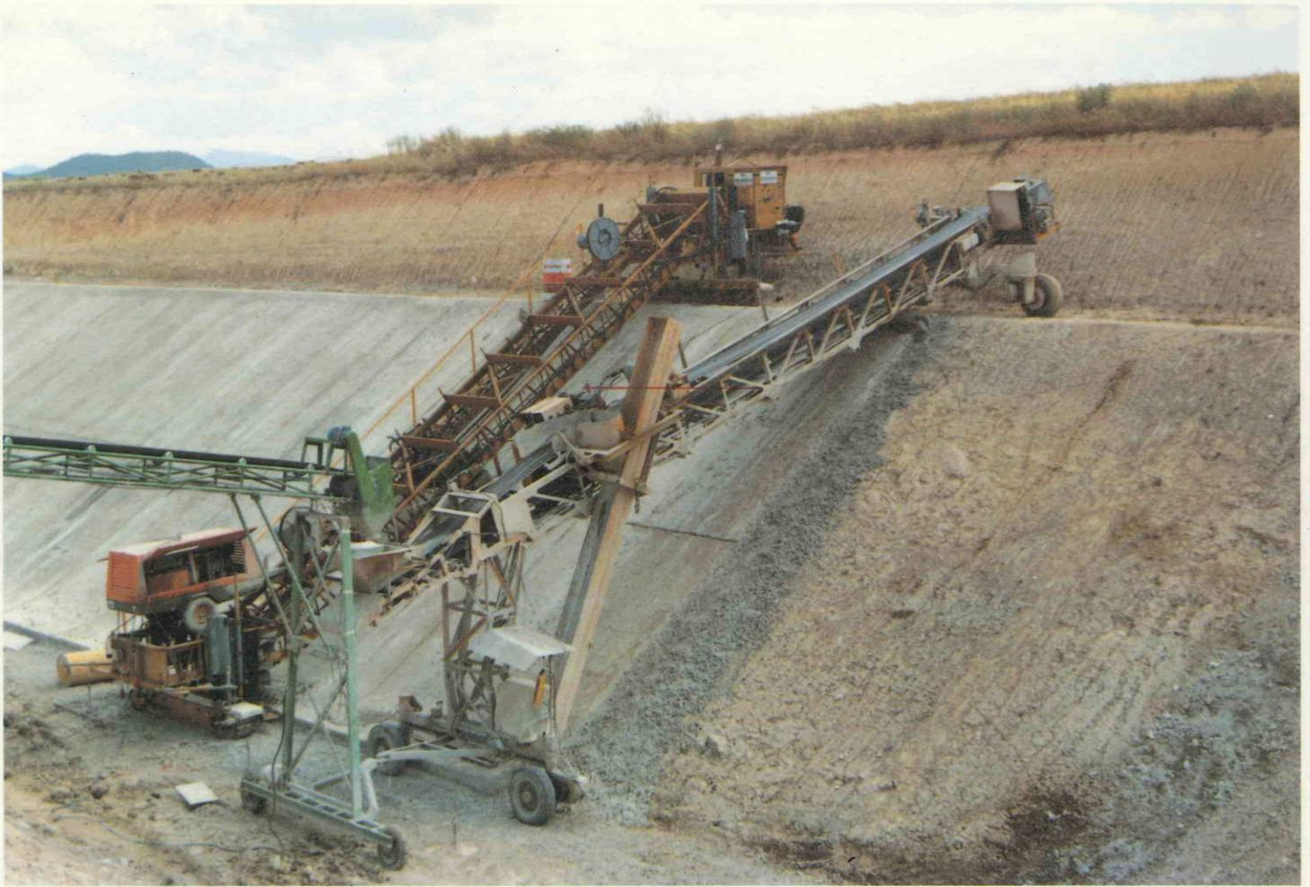
El revestimiento de cajeros se ha ejecutado con una revestidora talud marca Gomaco, alimentada con dos cintas de 13 m. cada una, dispuestas en serie, ejecutando en primera fase el talud de M.D. y en segunda fase y sentido contrario, el de M.I. Por último, se procedió a revestir la parte restante de solera con regla vibrante.
