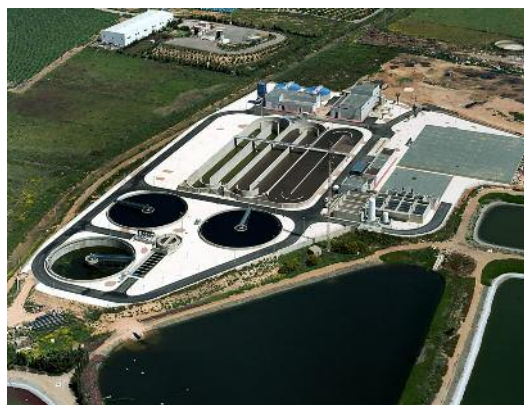
Depuradora de Los Alcázares
