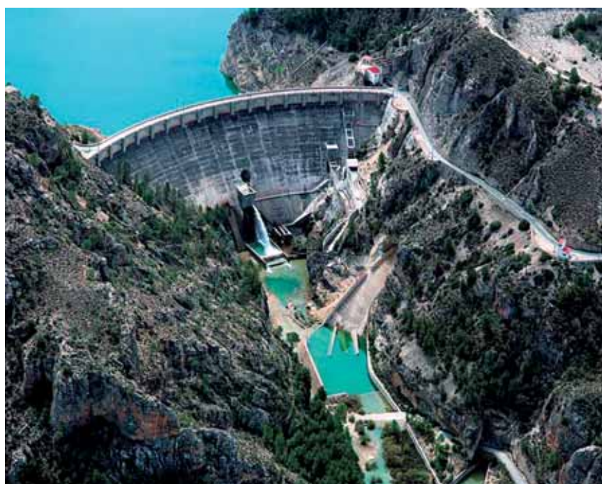
Presa del Embalse de la Fuensanta en Yeste (Albacete).
