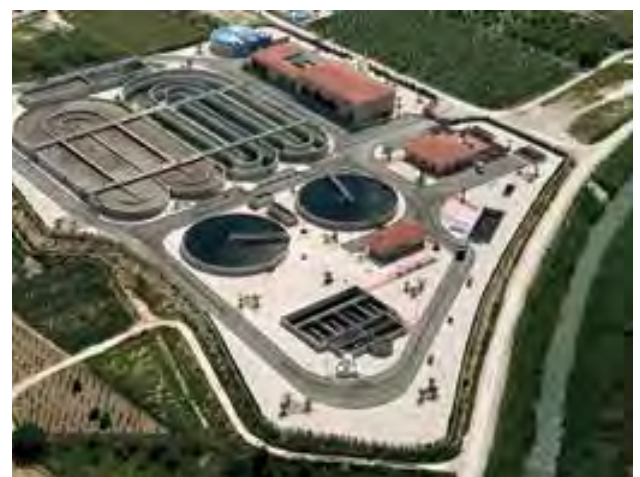
Above: Advanced wastewater treatment plant in the Murcia region (© Confederación Hidrográfica del Segura Press Office)
