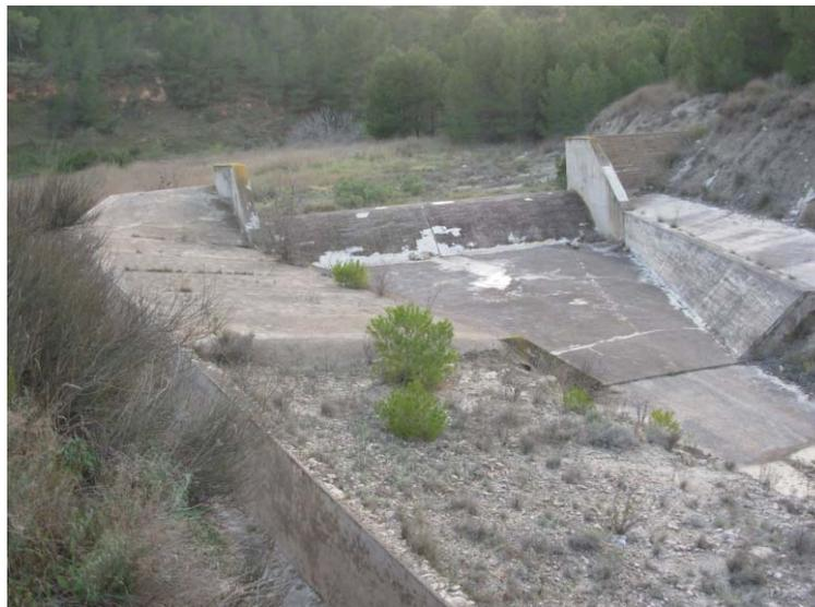
**Figura 6:** Detalle del aliviadero de la presa de derivación
