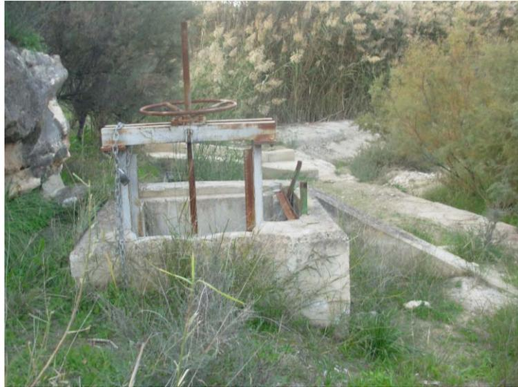
**Figura 5:** Punto de derivación: Acequia de Daya
