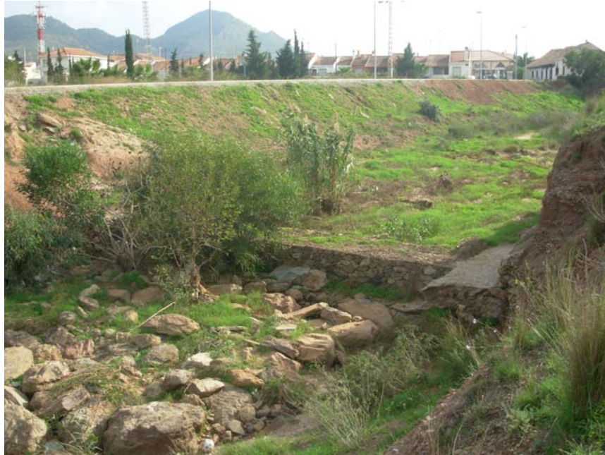
Fotografía 16: Albarrada en la rambla cerca del casco urbano
