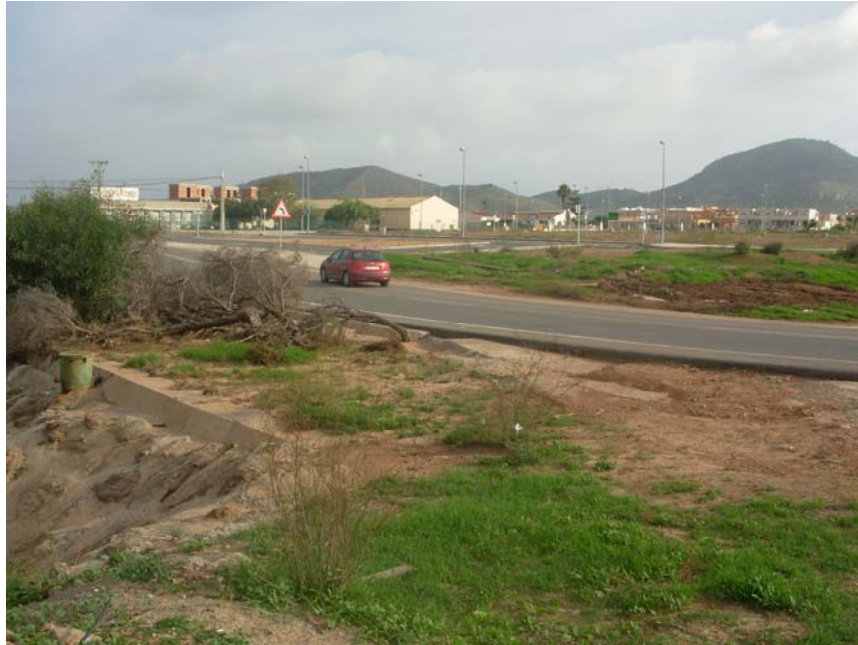
Fotografía 10: Paso de la carretera F-34 por el lecho de la rambla
