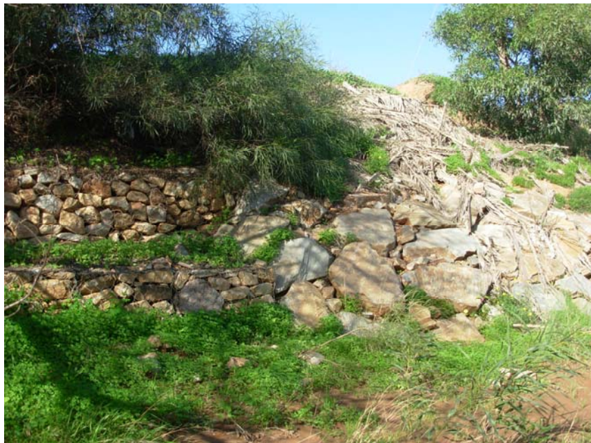
Fotografía 17: Continuidad del muro de gaviones con escollera.
