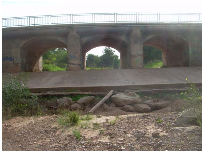
Fotografía 9: Puente de la calle Mayor de Los Belones
