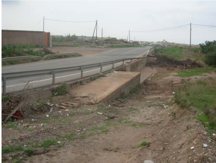
Fotografía 12: Paso de la carretera F-34 de acceso a Los Nietos
