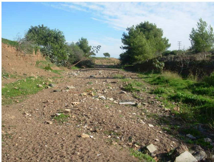
Fotografía 6: Tramo de la rambla donde se produce sedimentación y escombros.
