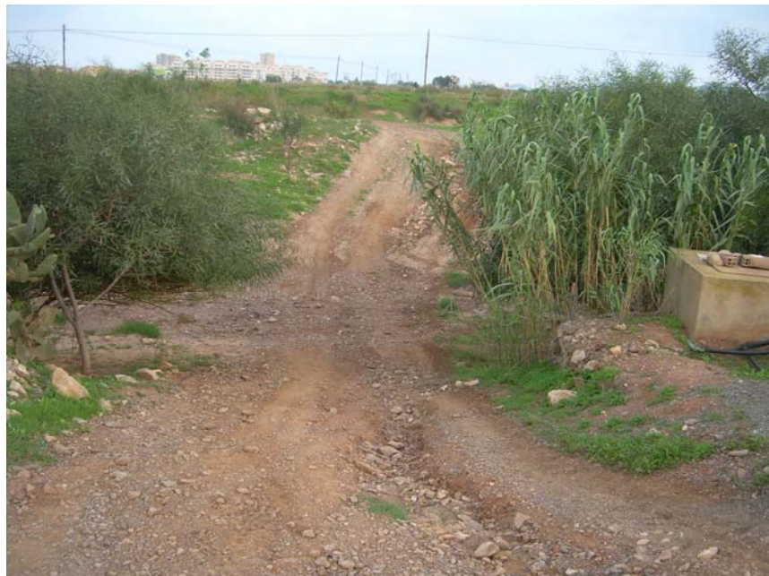
Fotografía 11: Camino de cruce por el lecho de la rambla
