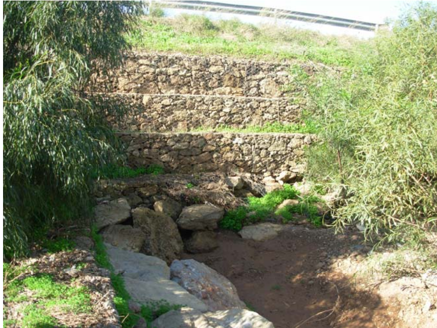
Fotografía 14: Muro y albarrada de gaviones
