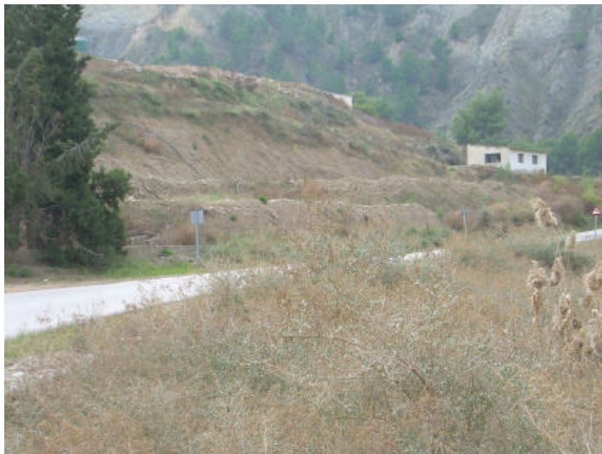
Figura 6: Planta de tratamiento de purines en margen derecha. Riesgo de lixiviados en episodios de intensas lluvias..
