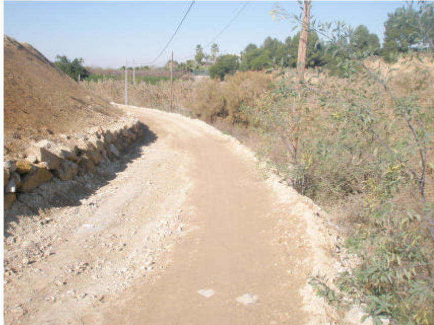
Figura 13: Tramo aguas abajo del dique de la boquera de Tiñosa. Terraplén parcela contigua y escollera de contención.
