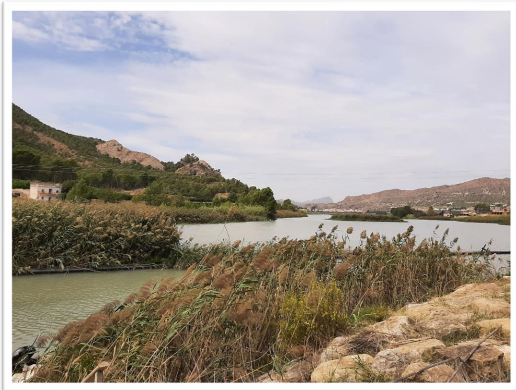
Foto 1. Azud de Ojós.
